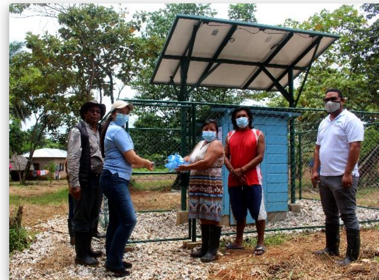
Inauguration du système de pompage solaire de Rama Maneland, Août 2021
